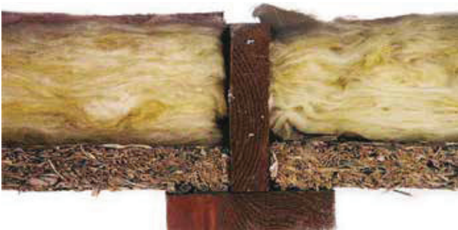
SCHNITT DURCH DIE PORENDECKE
